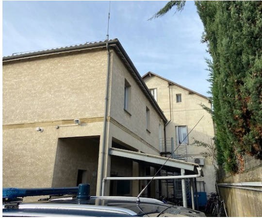
Vue bâtiment depuis cour intérieure
