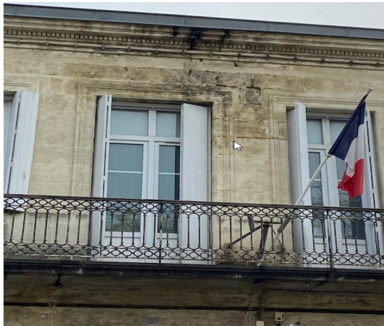
Façade cours Tourny
