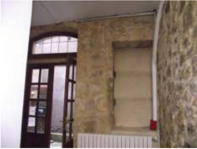
Entrée de l'immeuble (depuis cour)
