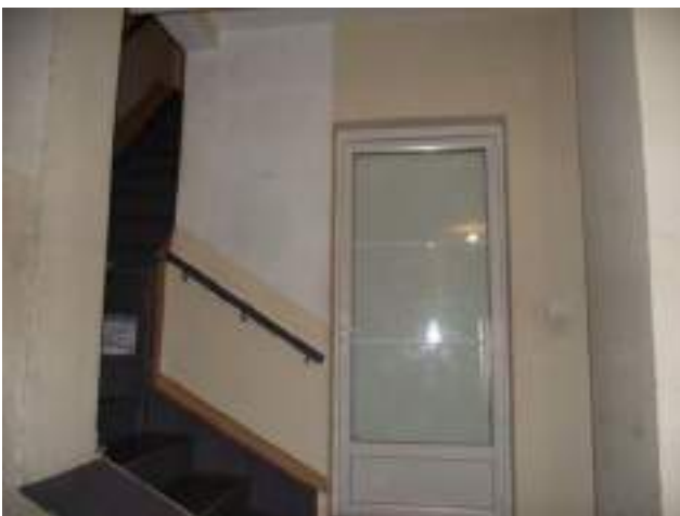
Porte PVC du logt RDC/B à gauche : découpe de l'ancien mur de façade du corps B puis départ de l'escalier bois vers logt R+1/B
