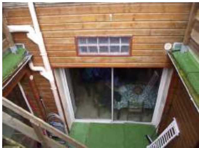
Vue sur cour 2 depuis la terrasse du logt RDC/B. Lambris bois sur maçonnerie. Gazon synthétique.
