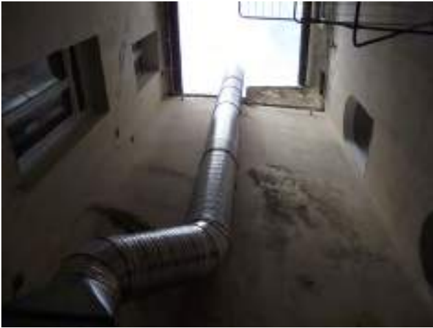
En face : mur côté 4 rue Thiers à droite : façade arrière du corps A (baies de la cage d'escalier) à gauche : façade sur cour du corps B enduites jusqu'en dessous de la verrière retirée (filet suspendu)
