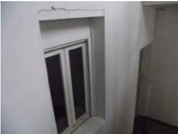
Baies arrières des logements du corps A
