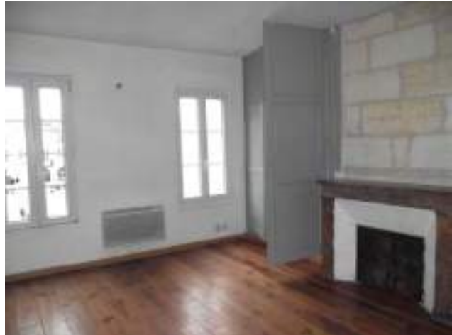
Séjour fenêtres PVC et garde-corps contemporains sur place A.Surchamp
