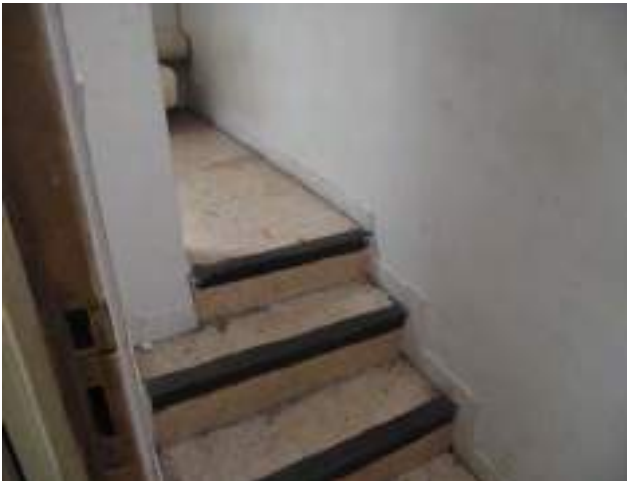
Entrée du logement (dégagement) marches montant vers le séjour
