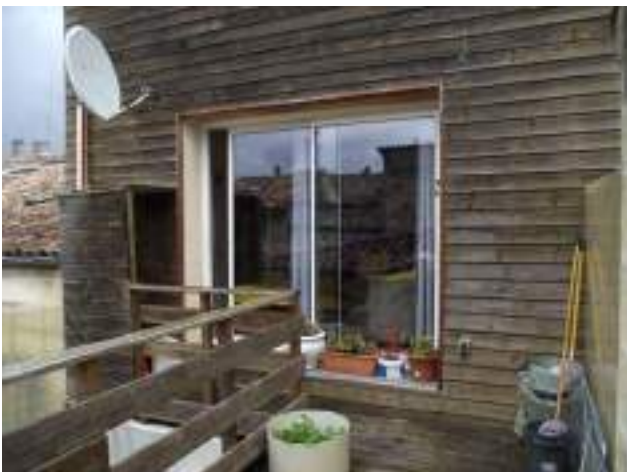
Façade arrière du corps A, depuis le balcon du logt R+2/A bardage bois (ossature bois?)
