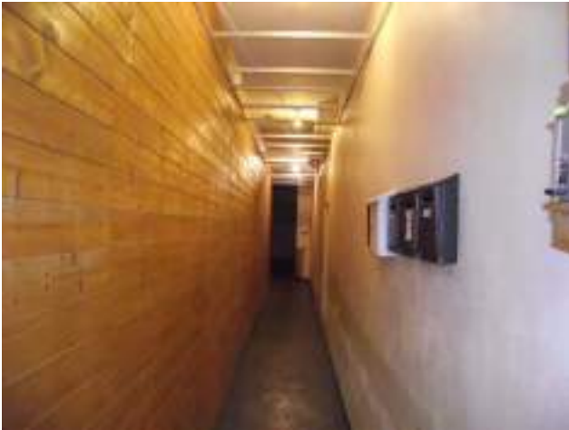
Couloir ossature de faux-plafond
