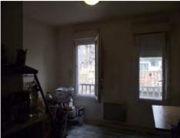
Séjour en cours de grand nettoyage fenêtres sur cour : garde-corps posés
