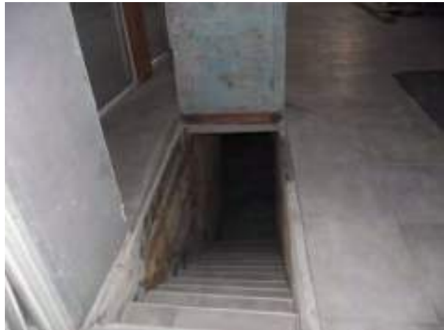
Trappe d'accès cave
