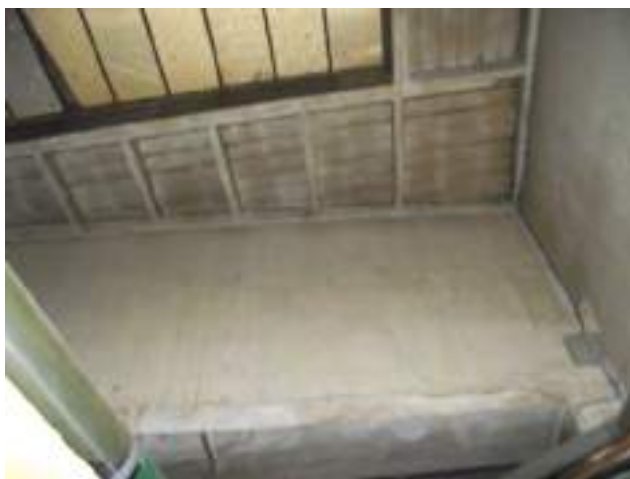
Verrière vue depuis la trappe en plafond du commerce
