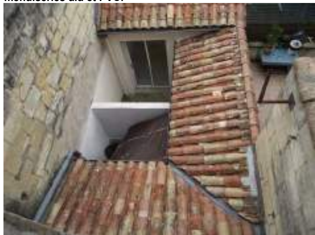
Arrière du corps A et corps B : organisés autour de la cour. Mur séparatif non protégé en tête. façade arrière du corps B, donnant sur jardin à l'usage du propriétaire : non visible.
