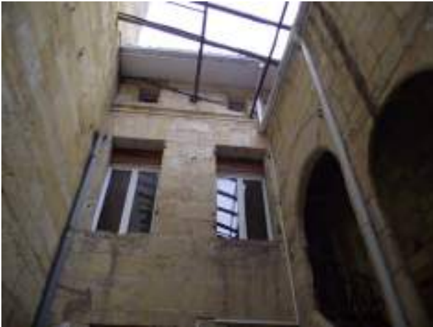
Façade corps C : étages baies remaniées, PVC. Ossature de verrière, ouverte
