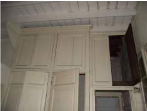
Séjour façade menuisère masquant l'escalier.
