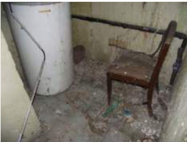
Cour ancien accès au wc cumulus commun avec le R+1/A/48.
