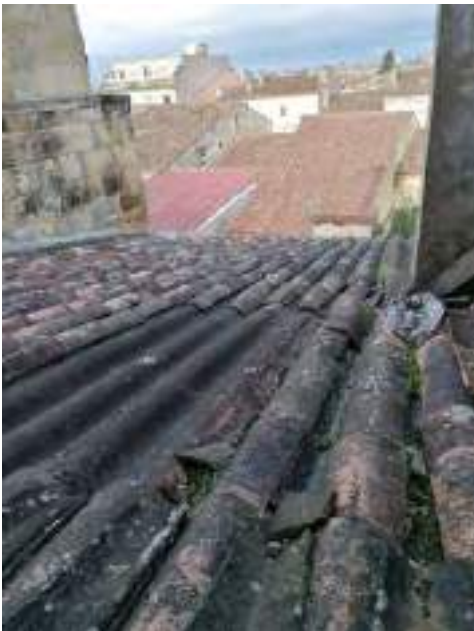
Toiture : pan arrière du corps A
