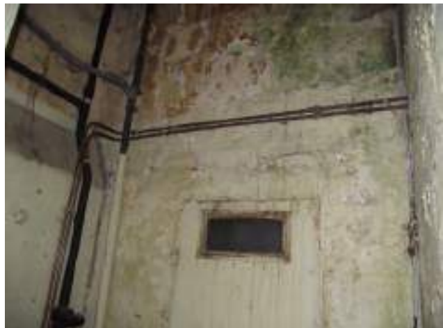
Ancienne porte wc sur courette wc-salle d'eau du logt R+1/Bduplex, bâti en enclave sur le fond voisin (52 rue Fonneuve)
