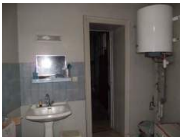
Salle d'eau Au fond : accès à la chambre
