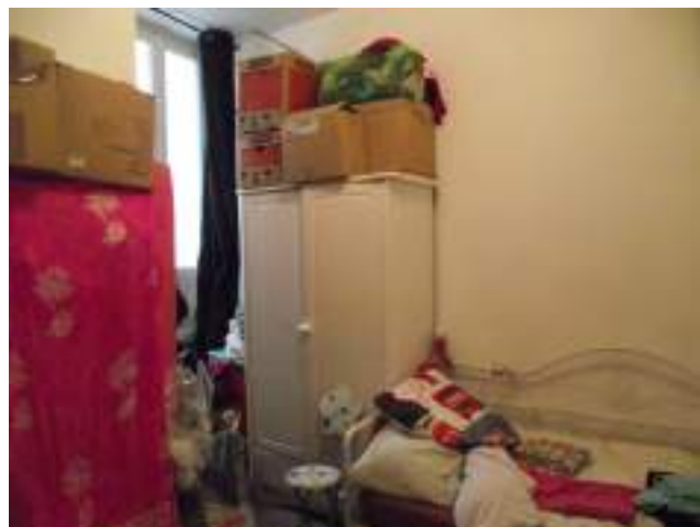
Chambre 1 : configuration insuffisante au titre du RSD fenêtre donnant sous onduline
