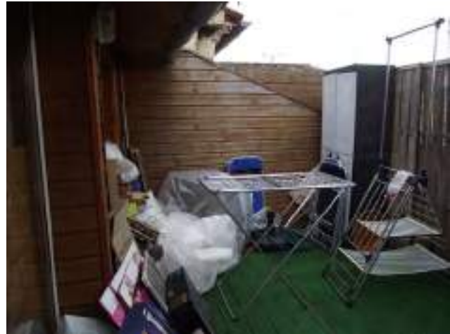
terrasse du R+3 habillage lambris de l'héberge du 62 rue Waldeck Rousseau ; pare-vue rapporté en panneau de bois léger
