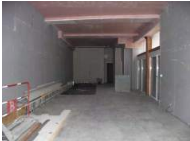
Vue depuis l'entrée sol carrelé, plafonds feu
