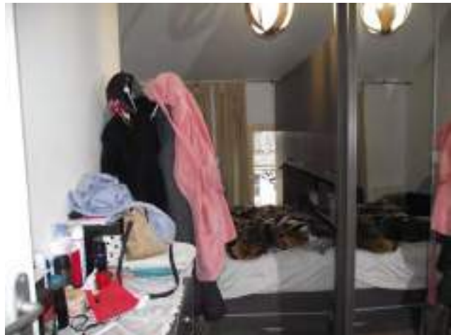
Chambre 1 configuration en L ne présentant pas une surface conforme au Règlement Départemental Sanitaire.
