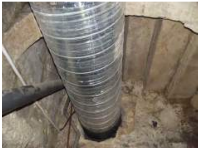
Accès cave sous-face des marches en pierre de la première volée escalier passage du boisseau d'extraction cuisine
