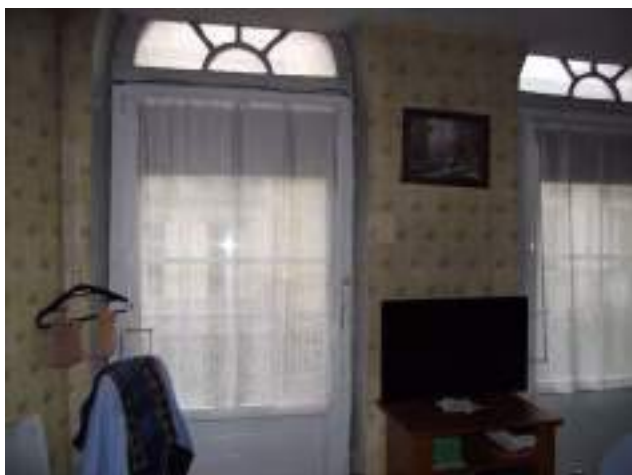
Séjour portes-fenêtres PVC avec impostes d'origine, donnant sur balcon
