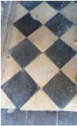
Entrée sol affaissé réparé, carreaux de ciment disjoints en cours de scellement
