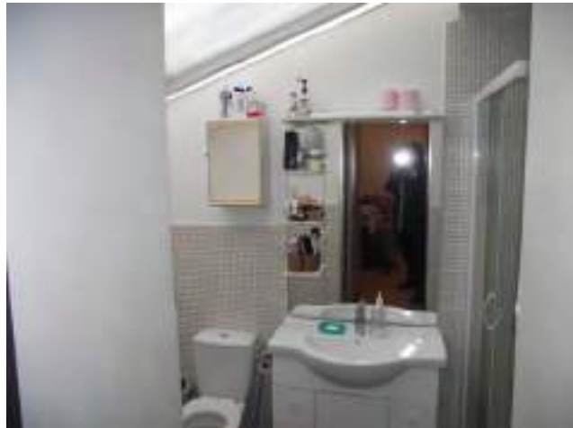
Salle d'eau, en emprise de la cour 1 sous couverture polycarbonate
