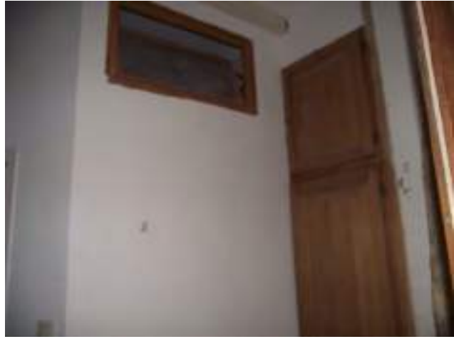
Vue depuis l'entrée : châssis du lot n°2 placard technique, comportant le rejet de la vmc du logt 2
