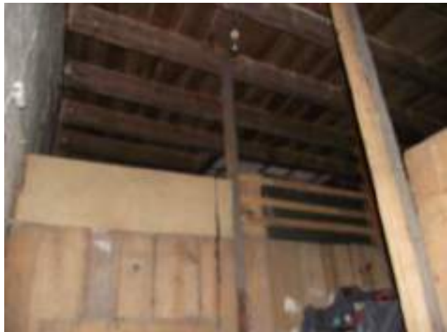
Celliers (ancienne activité?) en RDC corps C
