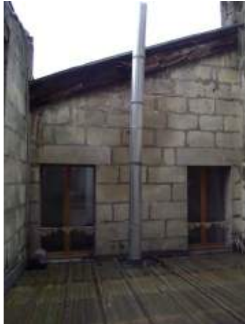
Cour : couverture onduline, boisseau (obsolète?), façade cour du lot 5 : joints ciments, menuiseries bois neuves
