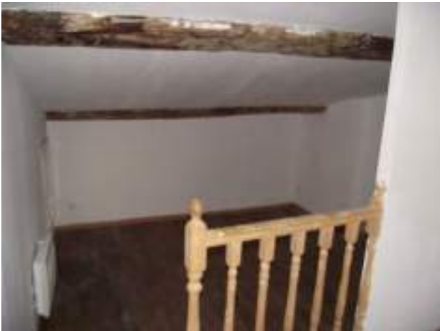
Mezzanine petite fenêtre PVC en héberge sur toiture du 20 place A. Surchamp
