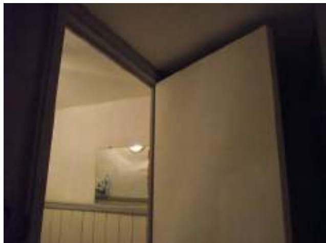
Sanitaires du personnel, plénum sous emprise escalier
