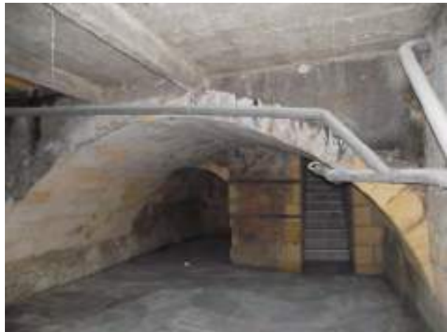
Cave voûtée cerclages des pilastres maintenus réseau d'évacuation vers égout (antenne neuve côté JS)
