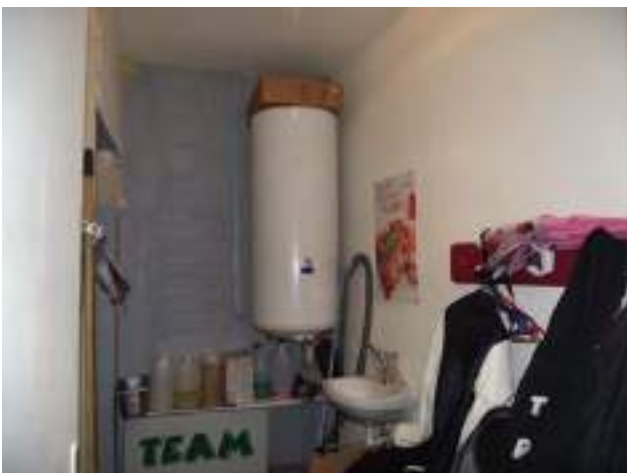
Vestiaires personnel, sous emprise verrière (masquée par les plafonds coupe-feu)
