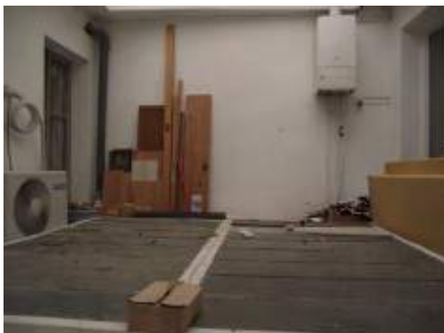
Niveau R+1 : cour couverte au sol : structure de verrière, dépôts, chaudière obsolète...
