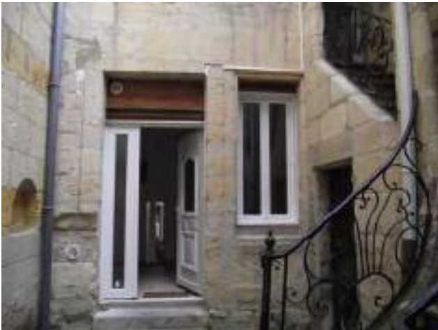
Accès au logement baies remaniées, menuiseries PVC
