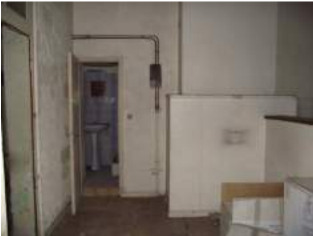
Séjour vue depuis l'escalier. Au fond : accès salle d'eau / à droite : coin cuisine
