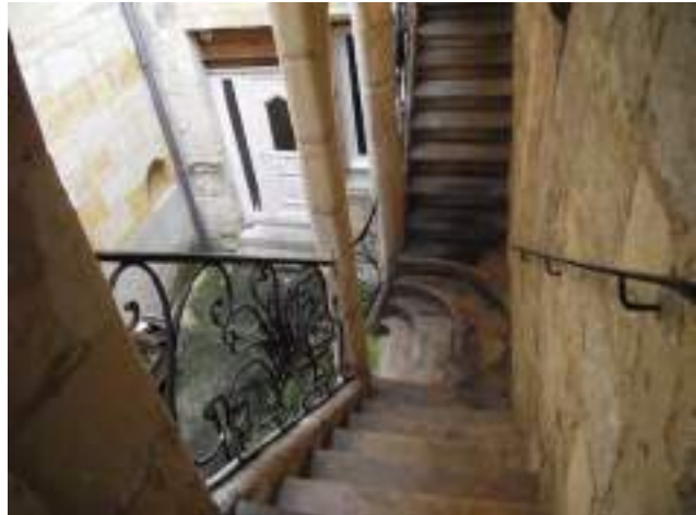
Cage d'escalier ouverte très bel escalier en pierre avec garde-corps ferronnier cour : en ciment, avec trappes (dont une d'accès à la cave, non vue)
