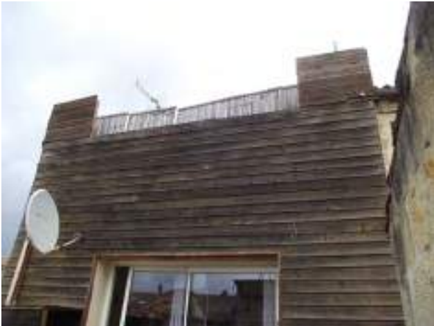
Façade arrière du corps A, depuis le balcon du logt R+2/A bardage bois (ossature bois?), menuiserie alu
