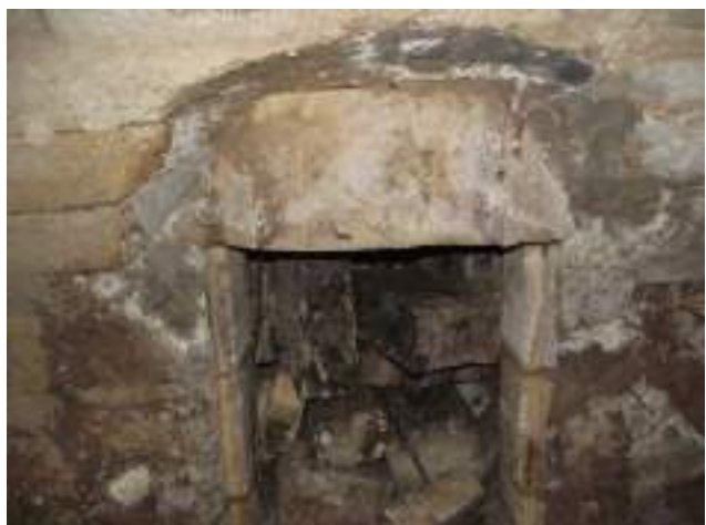
Puits en cave dépôts de pierres
