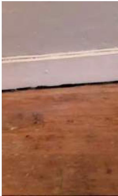
Plancher fléchissement
