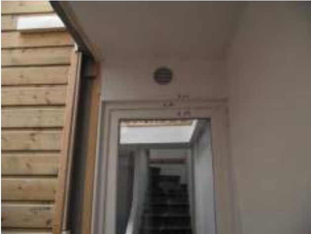
Accès du logement depuis la cour couverte
