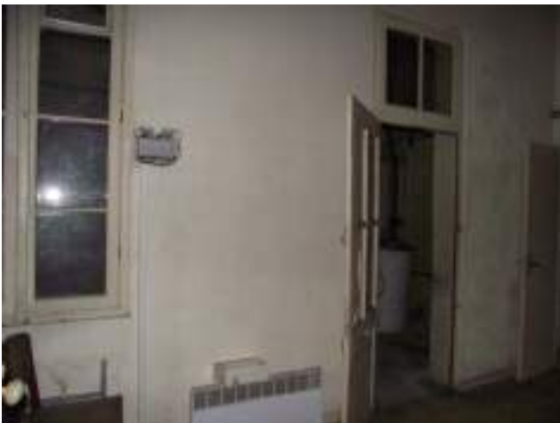
Séjour baies sur puits de jour. La porte-fenêtre donne accès à la petite cour.
