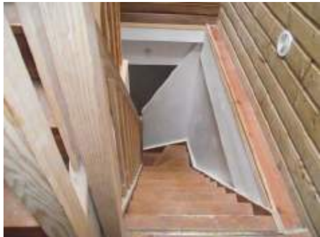
Escalier vue vers le RDC Escaliers très raides.
