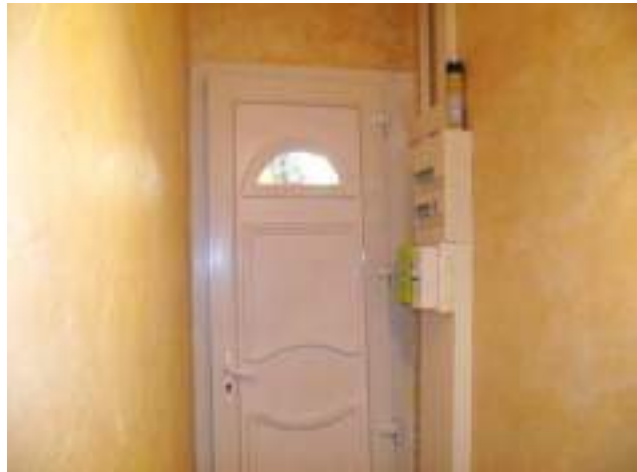
Couloir, porte palière PVC
