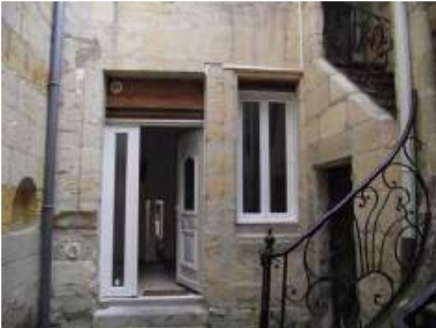
Façade corps C : rdc baies remaniées, PVC. à droite : petit cagibi sous escalier
