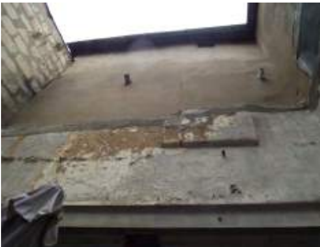
Façade Victor Hugo : zinguerie PVC, parement fendillé, joints altérés, balcon noirci traitement hétéroclite des baies
