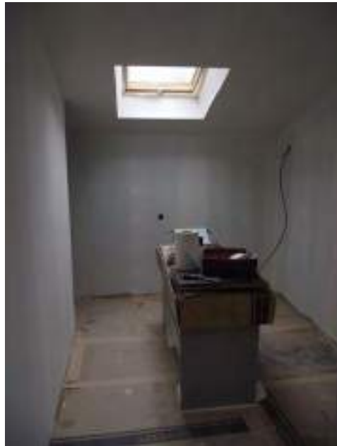
Future salle de bains, espace douche à gauche
