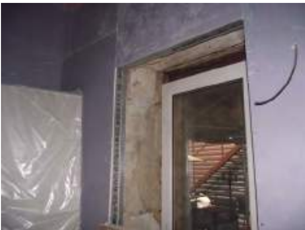
Fenêtre de la chambre donnant sur cour voisine
