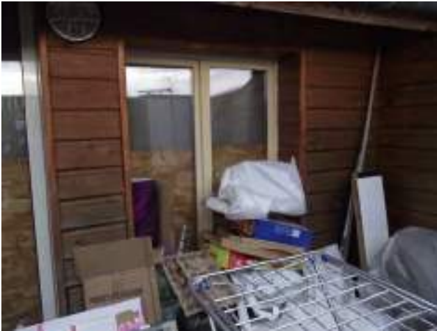
Façade arrière du corps A, terrasse du R+3 bardage bois (ossature bois?)
