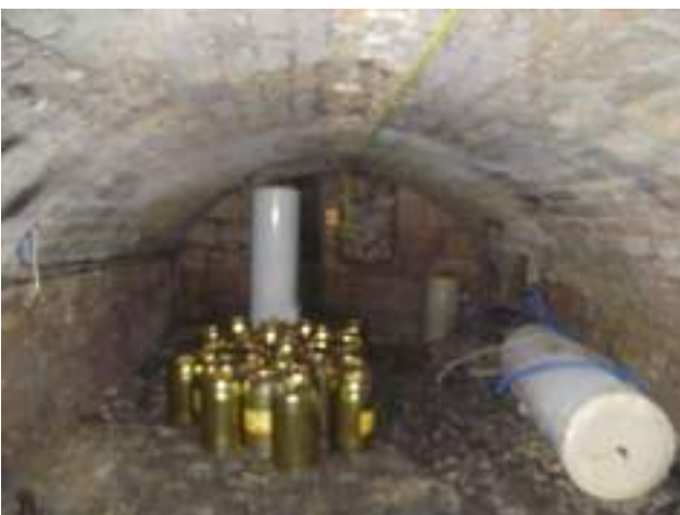
Cave voûtée saine, soupirail, 2 compteurs d'eau, 1 compteur gaz commerce Stockage : nota : la porte de cave n'est pas coupe-feu
