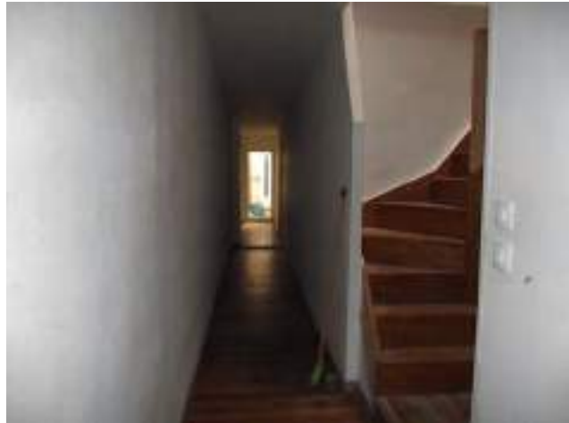
Couloir vue vers la cour arrière. A droite : cage d'escalier menant à la cour couverte
