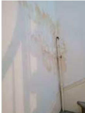
Cage d'escalier revêtement dégradé par l'humidité (dégât des eaux logt R+3 résorbé?)
