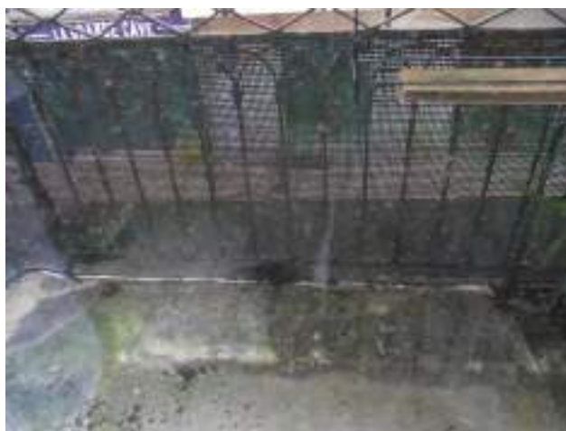
Balcon sur rue rétention d'eau
