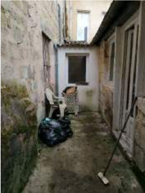
Courette et autres petits bâtis du corps B, à l'arrière des parcelles voisines
