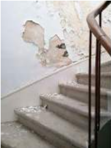
Cage d'escalier revêtement dégradé par l'humidité (dégât des eaux logt R+3 résorbé?)
