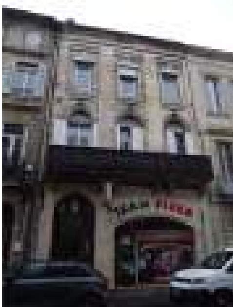
Façade Victor Hugo : zinguerie PVC, parement fendillé, joints altérés, balcon noirci traitement hétéroclite des baies
