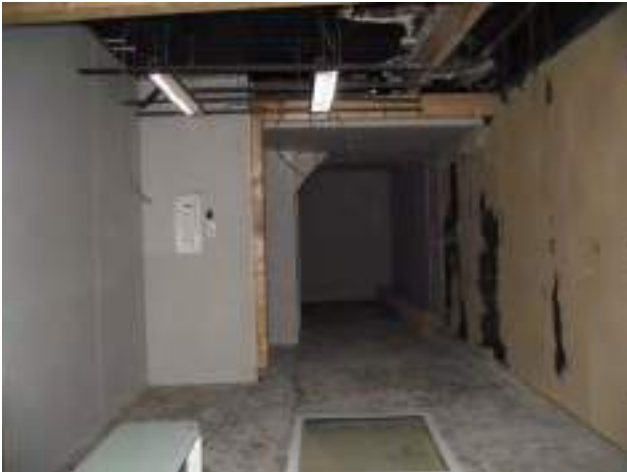
Local : vue depuis la vitrine en cours de travaux
