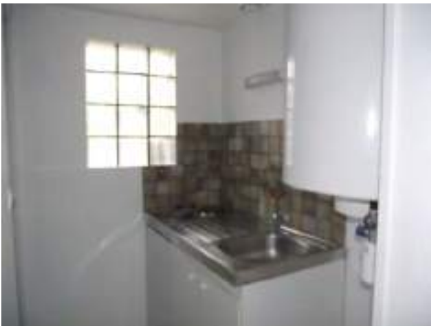
Alcove éclairée par le jardin : coin cuisine et accès salle d'eau
