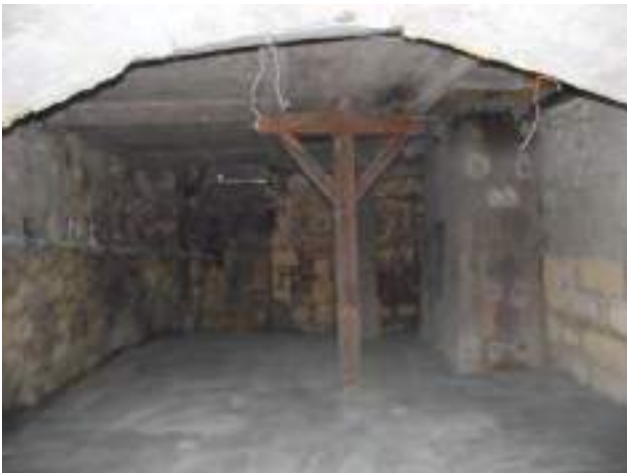
Étais maintenus sous plancher bois à droite : une zone de plancher ancien purgée
