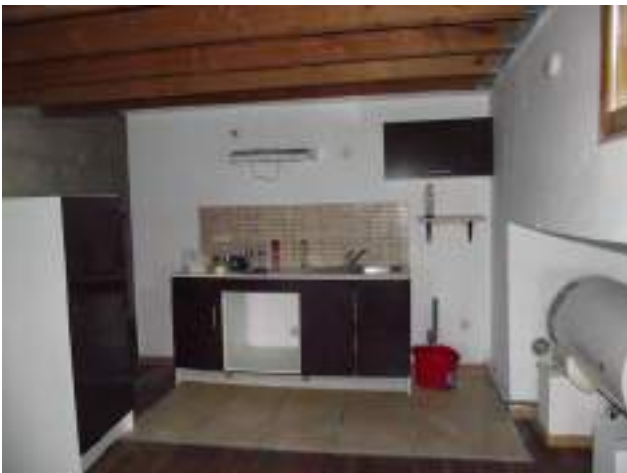
Coin cuisine fenêtre en héberge sur toiture du 20 place A. Surchamp Cumulus en niche sous toiture
