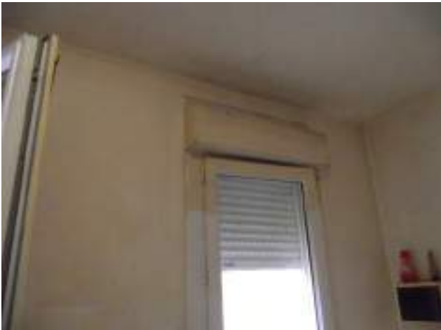
Détail séjour : partie basse nettoyée fenêtres et volets PVC, sans entrée d'air
