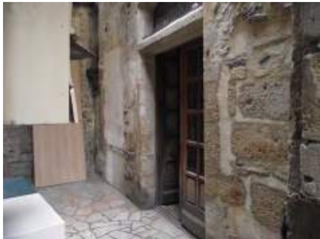
Cour et accès immeuble depuis l'impasse Dépôts, point d'eau, porte d'immeuble en bois simple vitrage, non close
