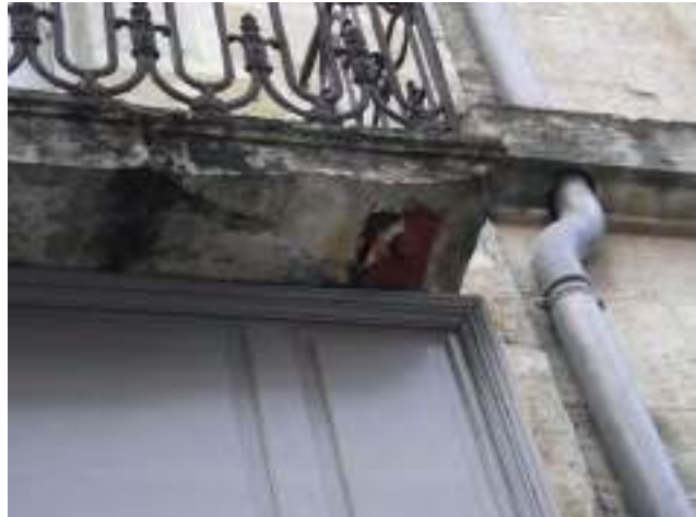
Reprise par UPN en 2016 suite à péril, derrière enseigne soutiens métalliques sous balcon, fuites et épaufures
