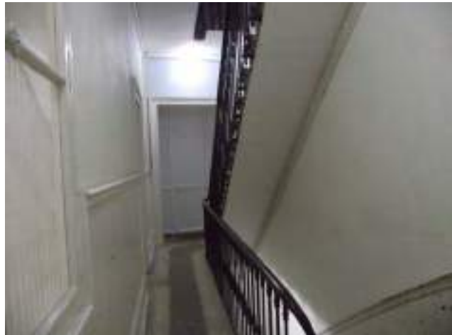
Palier R+1, joli dallage à gauche : fenêtre bois simple vitrage donnant sur la cour, sous onduline
