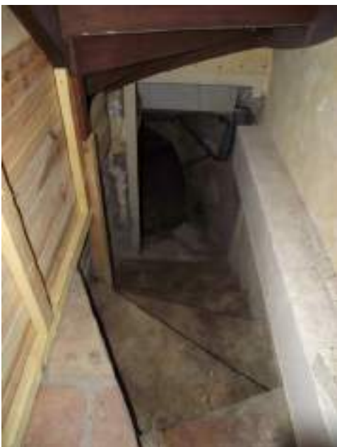
Accès cave un simple panneautage sépare l'accès de la cage d'escalier
