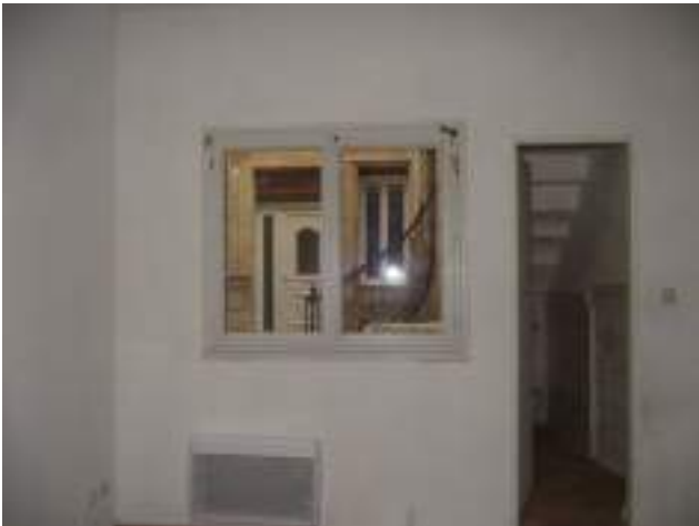
Séjour fenêtre PVC donnant sur la cour ouverte à droite : accès aux wc, situés sous l'escalier de la cour
