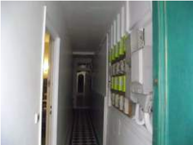
Couloir d'entrée : sol en carreaux de ciment compteurs et boîtes aux lettres en saillie
