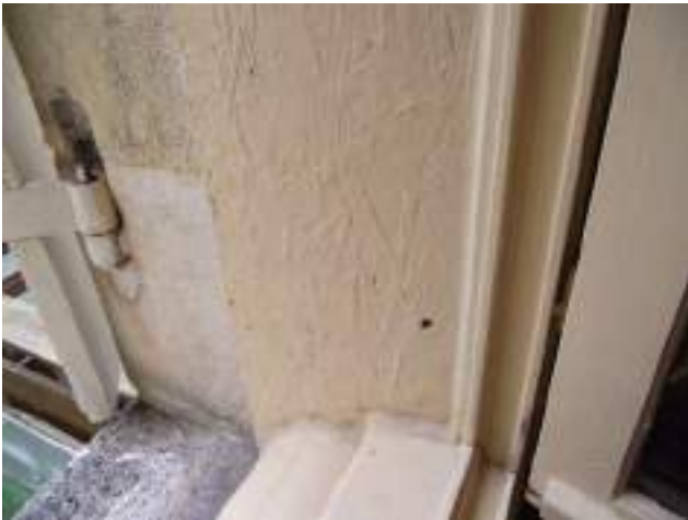
Détail baies des chambres : tapées en OSB peint
