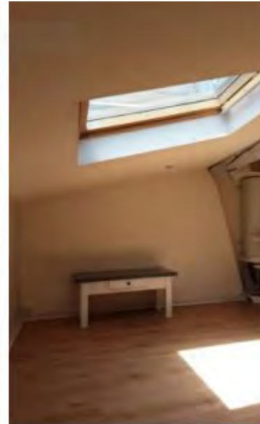
Séjour sous pente moins de 2m2 sous une hauteur de 2,20m : non conforme RSD
