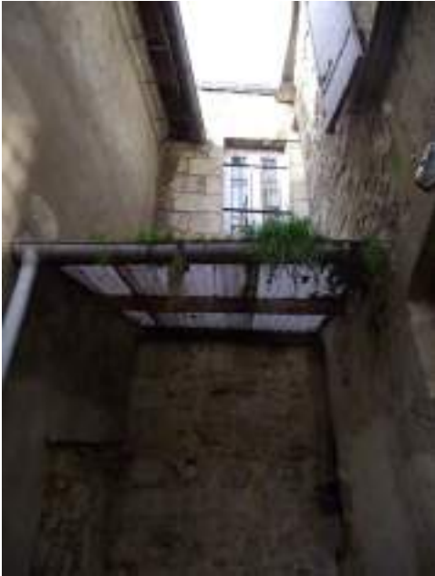
Onduline herbue couvrant partiellement la cour A gauche : héberge du 23 impasse Jules Simon Au fond : Héberge du 38 rue Victor Hugo (avec fenêtre) A droite : façade arrière du corps B
