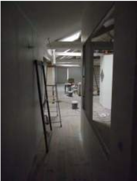
Entrée, espace sur cour à droite
