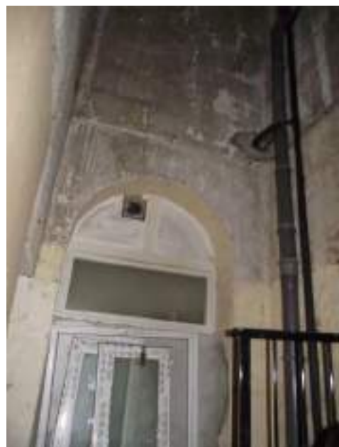
Ancienne baie remaniée donnant sur wc du logt RDC/A-B/46 Dépôts
