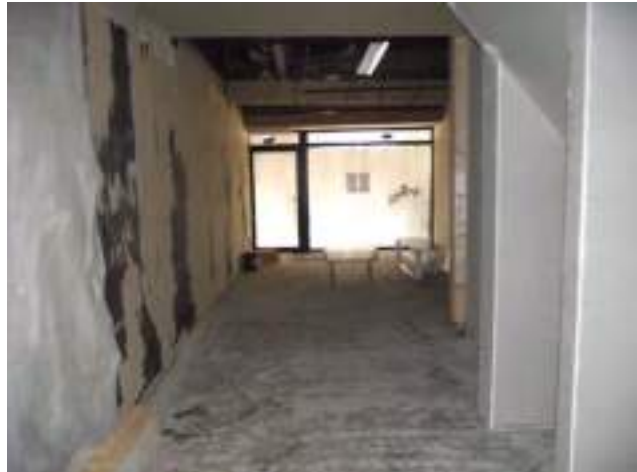
Local : vue vers la vitrine à droite : cage d'escalier des communs.
