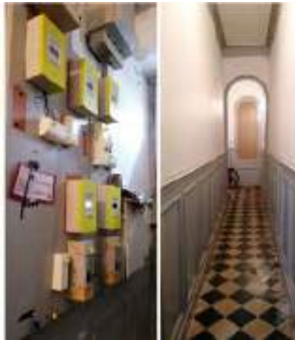
Couloir sol altéré (humidité?)
