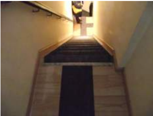
Escalier bois menant au R+2 neuf, très raide (idem pour escalier r+3)
