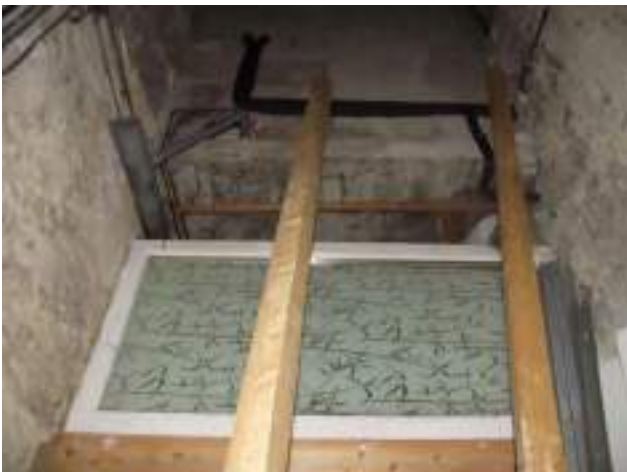
Cloisonnement sommaire de la salle d'eau du logt RDC/48 passage réseaux humides
