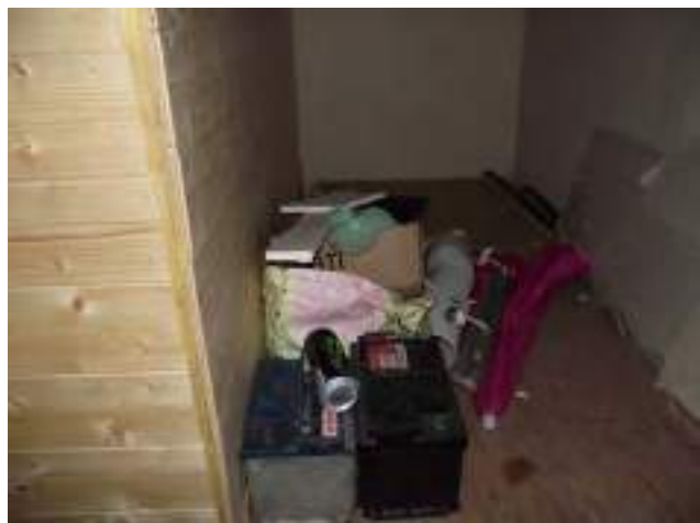
Trappe au sol d'accès à la cave protection au feu trappe et parois garage à avérer
